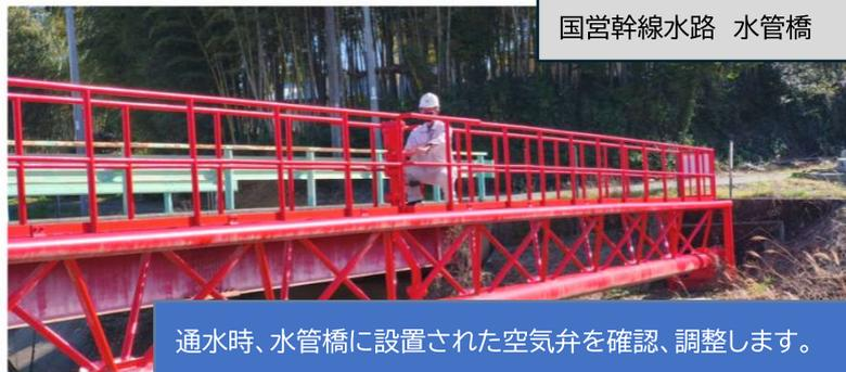
通水時、水管橋に設置された空気弁を確認、調整します。
